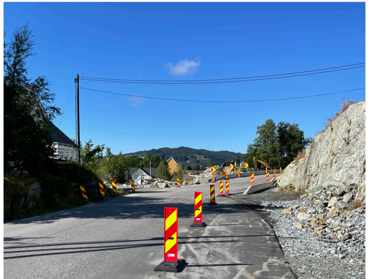
Arbeid pågår i Hatvikvegen i Bjørnafjorden. Foto: Anders Kjetland.
