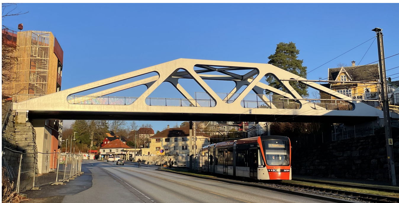
Med sine 42 meter er Paradis bru den lengste komposittbrua for i verda. Foto: Silje Alvsaker/Vestland fylkeskommune
