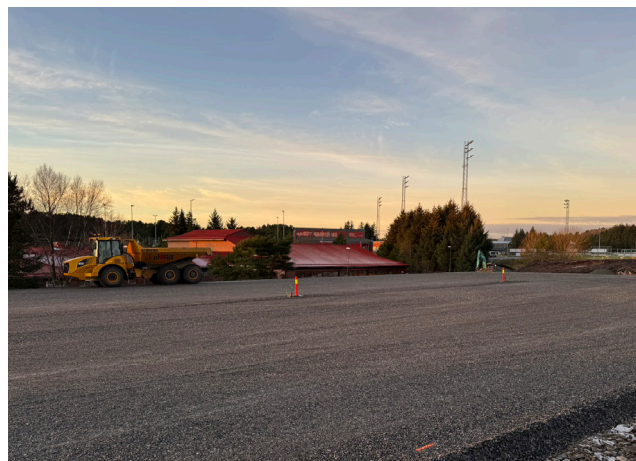
Innfartsparkering Ågotnes. Foto: Råmund Skjold
