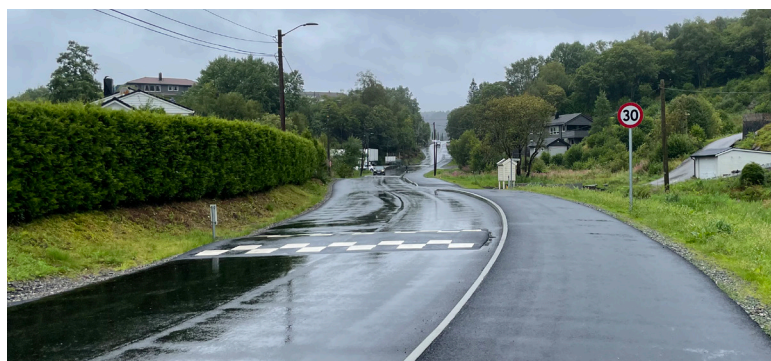
Kvernhusdalen på Askøy, ferdig opprusta med fortau. Foto: Anders Kjetland.
