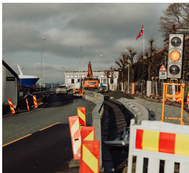
Arbeid med sykkelstamveg mellom Bradbenken og Glass Knag. Foto: Karoline Rage/Statens vegvesen.
