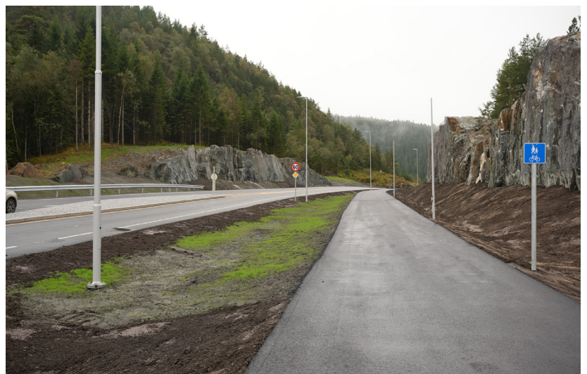
Etablering av gang- og sykkelveg Åsen-Helleskaret i Bjørnafjorden. Foto: Silje Alvsaker.
