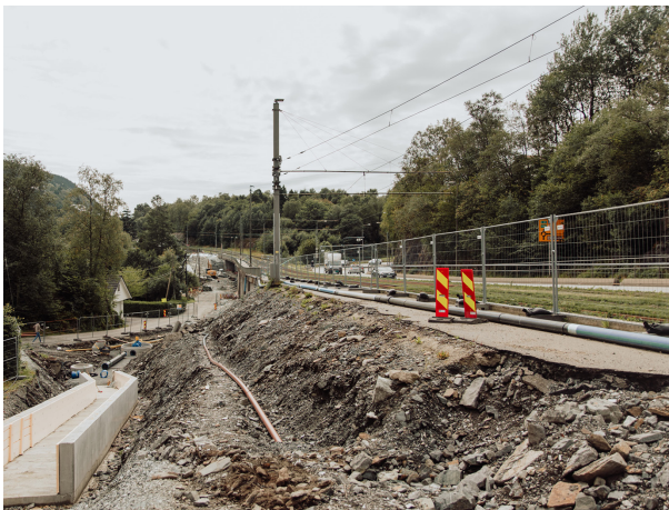
Det pågår arbeid med sykkelstamveg mellom Nesstun og Skjold. Foto: Karoline Rage/Statens vegvesen.
