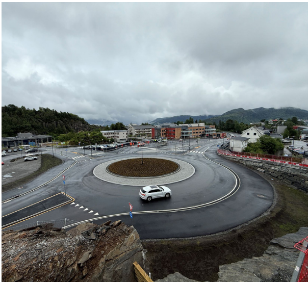
Myrane på Askøy har fått bedre infrastruktur. Foto: Dag Folkestad.
